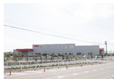
Das neue Werk in Nagoya
