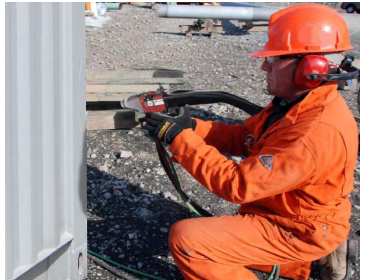
Reparatur eines Containers durch Aufbringung einer Zink-Aluminium Schicht
