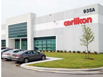
Das neue Beschichtungszentrum in Guelph, Kanada
