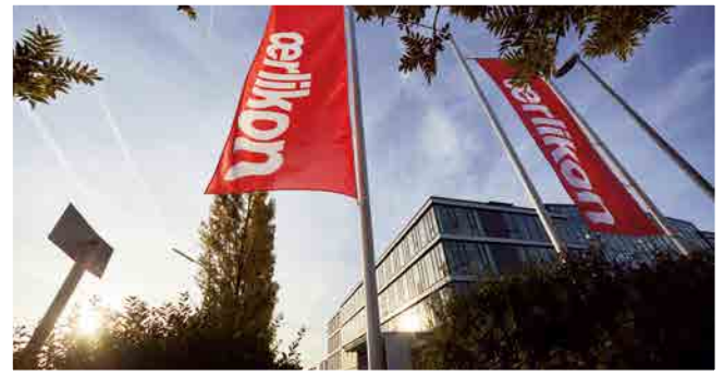
Außenansicht des Additive Manufacturing Technology and Innovation Center von Oerlikon.
